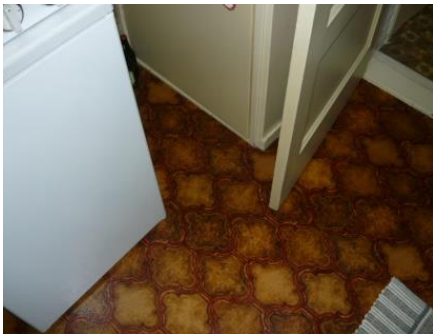
Voorbeelden asbesthoudend vloerzeil
